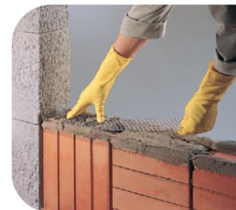
A junta horizontal de argamassa deve ser plenamente preenchida na posição onde as telas serão colocadas. O mesmo cuidado deve ser observado na junta vertical entre parede e pilar. Abaixar a tela, fazendo com que a tela fique perpendicular à parede e a argamassa penetre na malha da tela.
