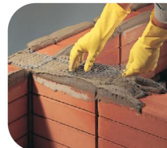
Neste caso o procedimento é o mesmo excetuando-se as operações de preparação do pilar e fixação da tela. A tela deve ser posicionada de modo a transpassar a parede a ser amarrada em pelo menos o comprimento de bloco, observando-se sempre o que recomenda o projeto de alvenaria.
