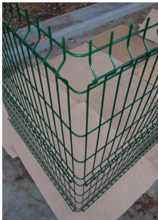
Em casos de cantos arredondados, dependendo do ângulo, não é necessário fazer a dobra do painel - basta cortar o fio que compõe o vinco e fazer a instalação. O painel se ajustará à curvatura.
