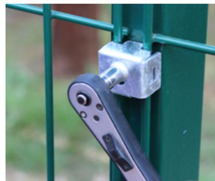
Posicione o **Parafuso Antifurto Morlan®** e aperte até o ponto onde acontece a quebra da cabeça do parafuso. Pode ser fixado com parafusadeira elétrica ou chave de boca.
