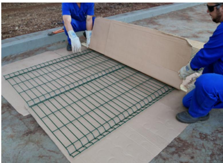
Se preferir utilizar um sarrafo de madeira, ele deve ser maior do que o painel, e precisa ter uma proteção de papelão entre o sarrafo e o painel. Firme as extremidades do sarrafo no chão (sem pisar no painel) e puxe as extremidades do painel para formar a dobra.
