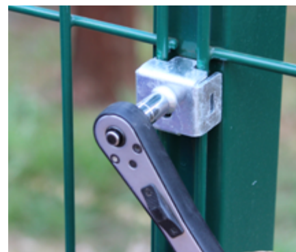
Posicione o fixador de segurança no poste.
