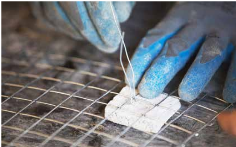
Figura 15 - Posicionamento do espaçador na tela
