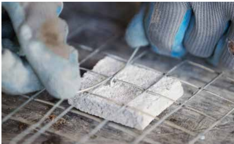
Figura 16 - Fixação do espaçador na tela
