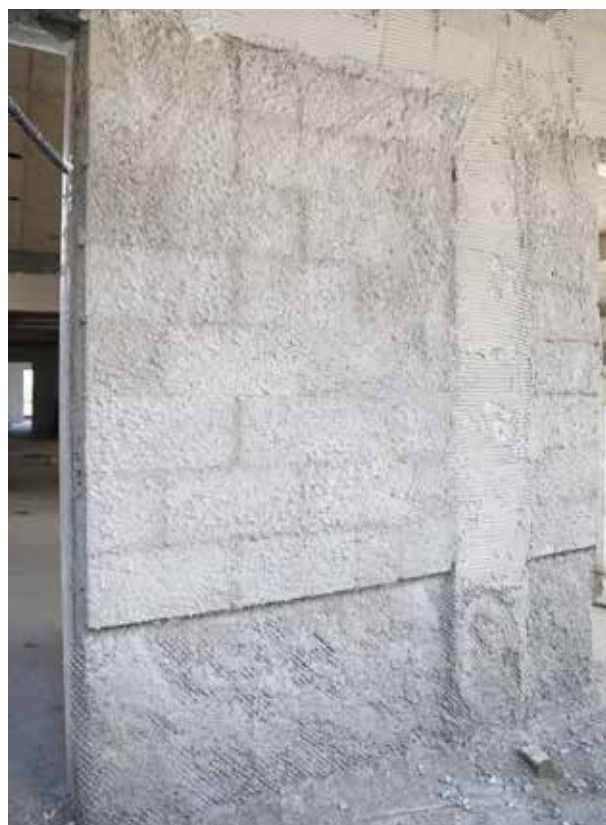
Fig. 11 - Chapisco e alvenaria encunhada
