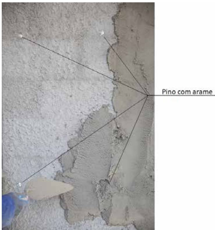
Fig. 27 - Posicionamento dos pinos com arame
