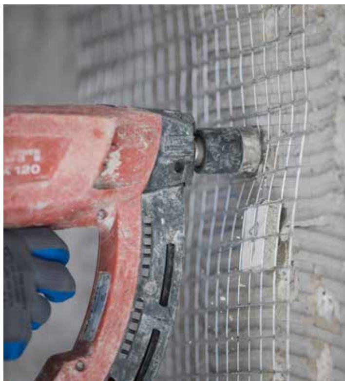
Fig. 22 - Fixação da FACHAFORTE® com pistola fincapino
