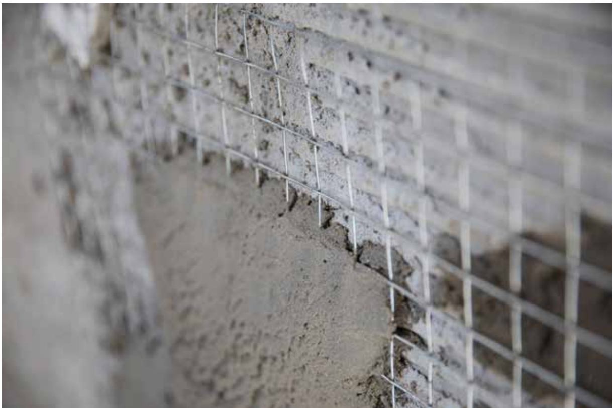
Fig. 25 - Passagem da argamassa através da FACHAFORTE®
