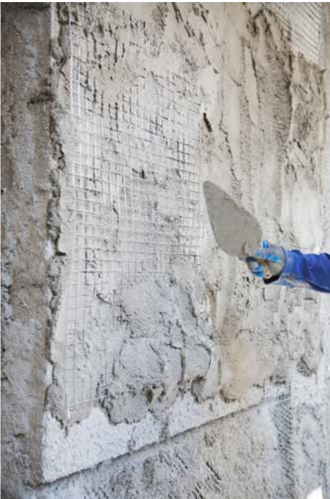
Fig. 33 - Aplicação da última camada de argamassa
