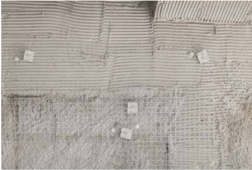
Fig. 20 - Posicionamento da FACHAFORTE® no encontro entre a viga e alvenaria
