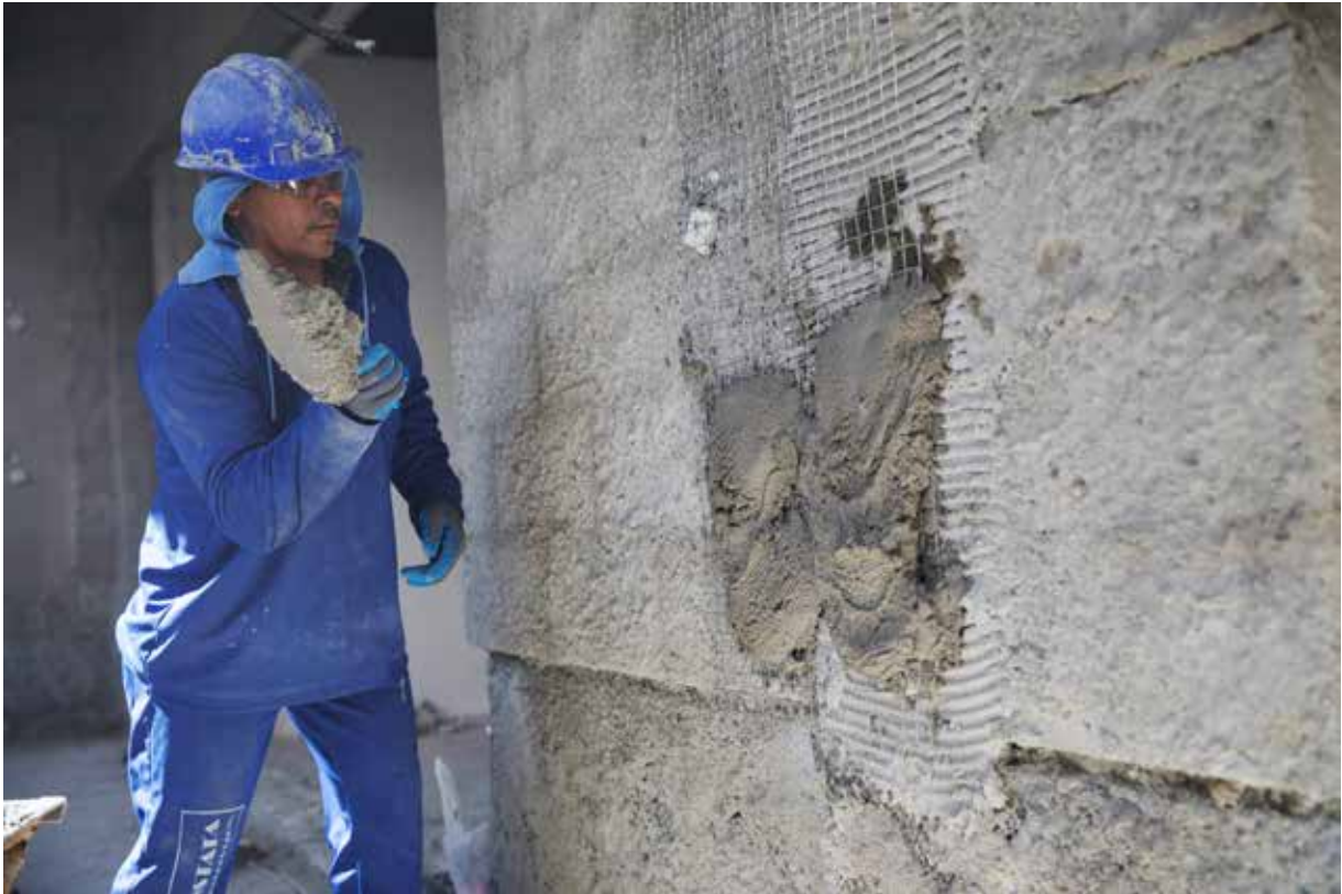
Fig. 24 - Aplicação da argamassa
