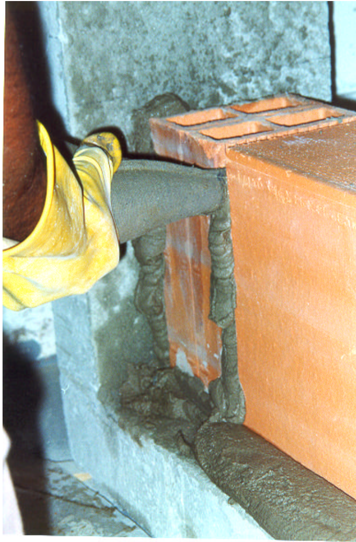
Figura 23 - Preenchimento da junta vertical de argamassa com auxílio de uma bisnaga.
