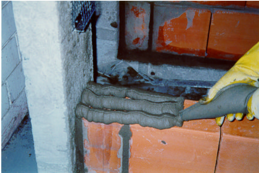
Figura 24 - Colocação de argamassa com uma bispaga na junta horizontal para assentamento dos blocos.
