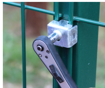
Posicione o fixador de segurança no poste.
