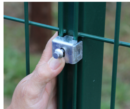
Posicione o fixador de segurança no poste.
