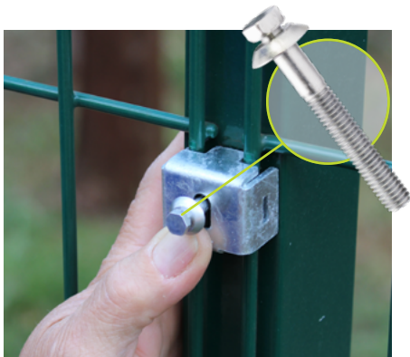
Retire a tampa do fixador de Nylon.
