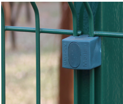
Retire a tampa do fixador de Nylon.
