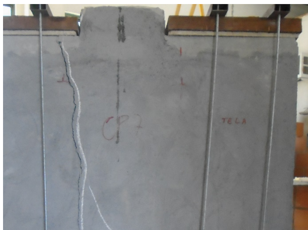
Figura 51 - Fissura no revestimento após a ruptura
