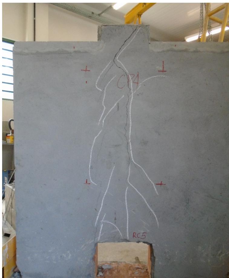
Figura 32 - CP após ruptura - Parede 4
