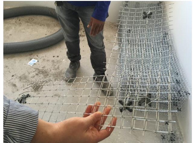
Figura 7 - Transpasse da tela metálica para reforço dos cantos
