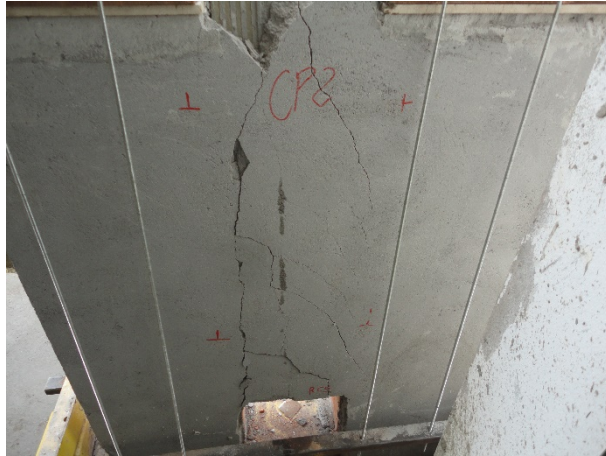
Figura 45 - CP 2 após ruptura
