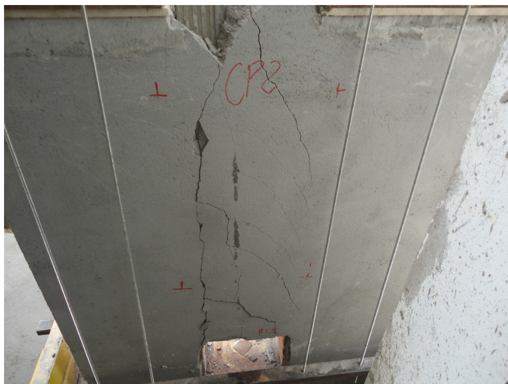
Figura 30 - CP após ruptura - Parede 2
