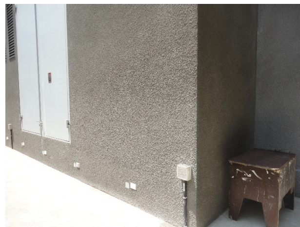
Figura 24 - Extremidade da parede sem fissuras visíveis
