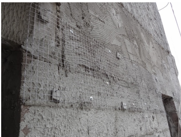
Figura 3 - Fixação da tela com o uso de pinos e espaçadores
