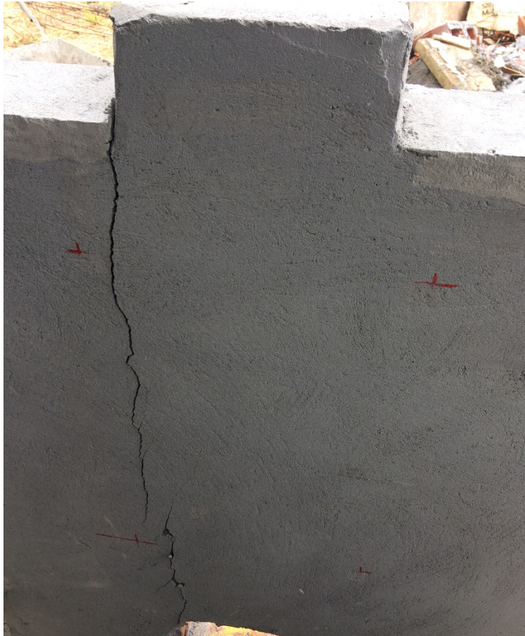
Figura 31 - CP após ruptura - Parede 3
