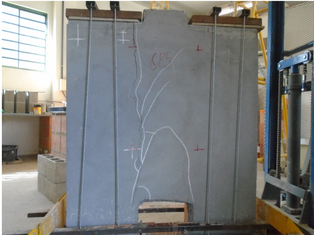
Figura 33 - CP após ruptura - Parede 5
