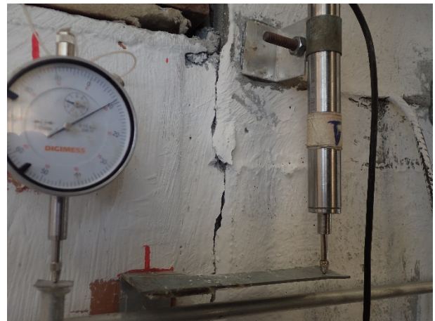
Figura 42 - Surgimento da fissura
