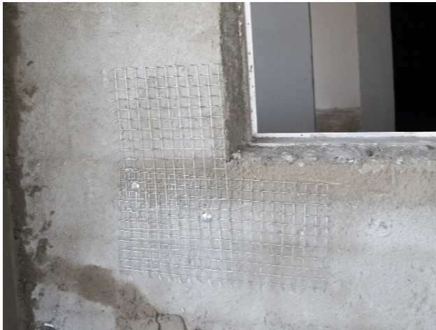
Figura 6 - Tela metálica fixada no canto da janela
