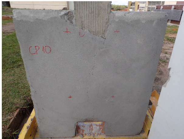
Figura 49 - CP 10 após ruptura
