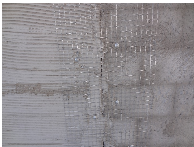
Figura 5 - Tela metálica na interface alvenaria - pilar
