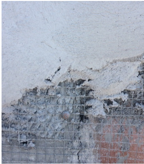
Figura 29 - Tela de reforço para combater fissuras no revestimento
