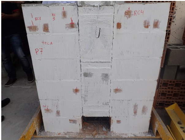
Figura 43 - Ruptura da interface entre alvenaria e pilar de concreto
